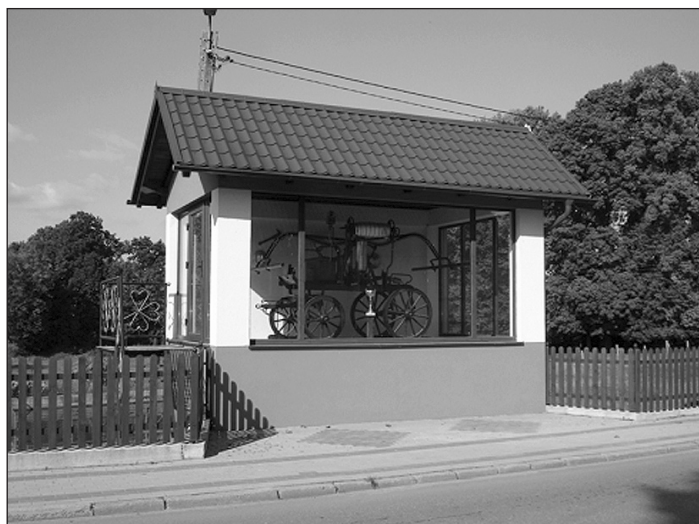
Wyremontowana remiza w Zakrzewie
