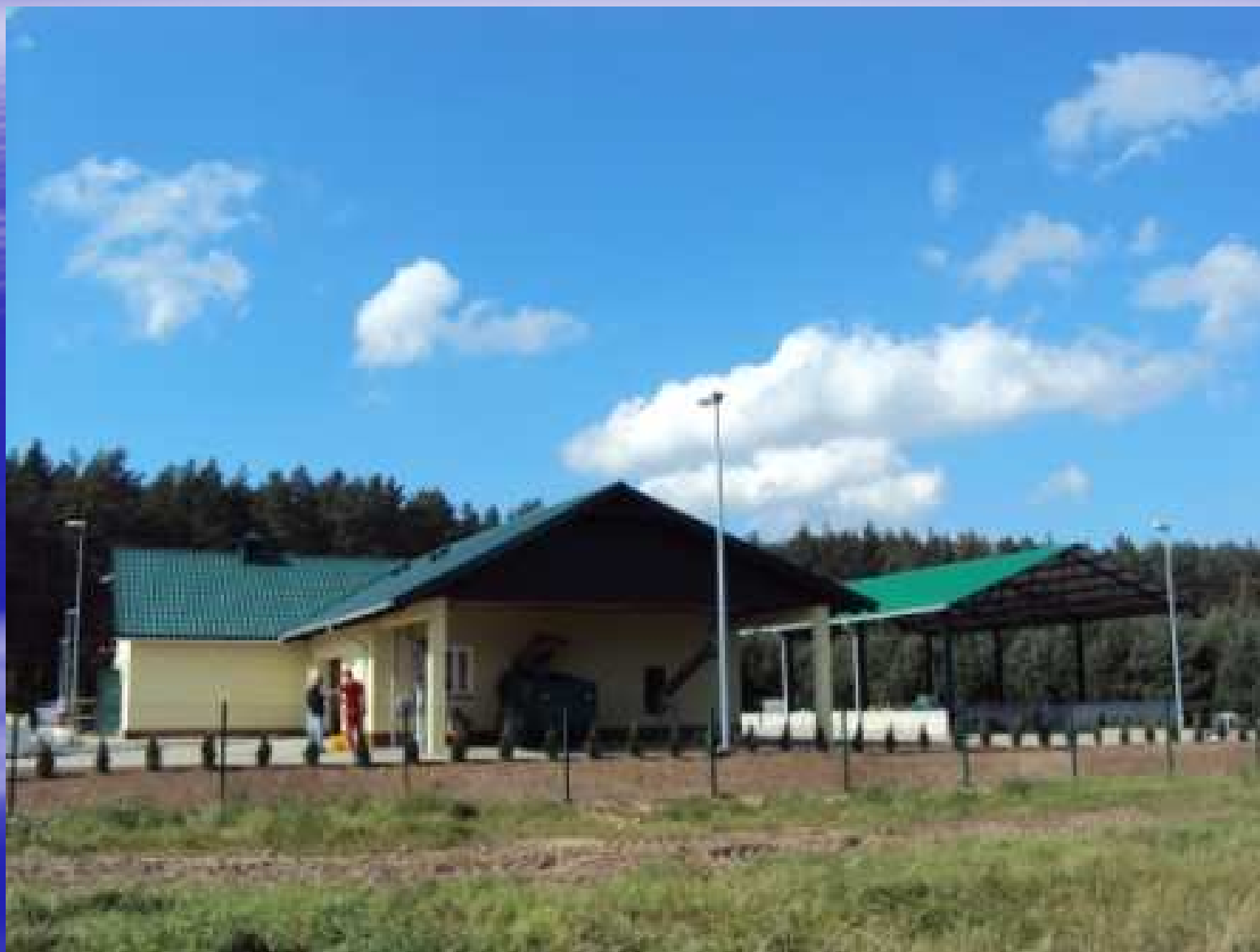
Rozbudowa oczyszczalni ścieków w Tłuczewie
