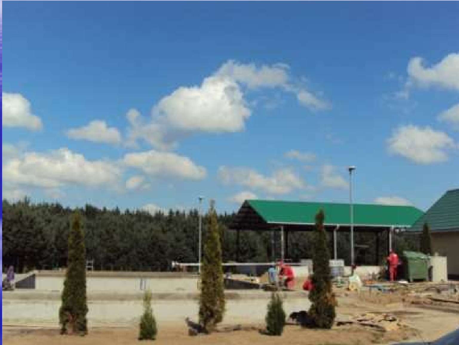
Rozbudowa oczyszczalni ścieków w Tłuczewie
