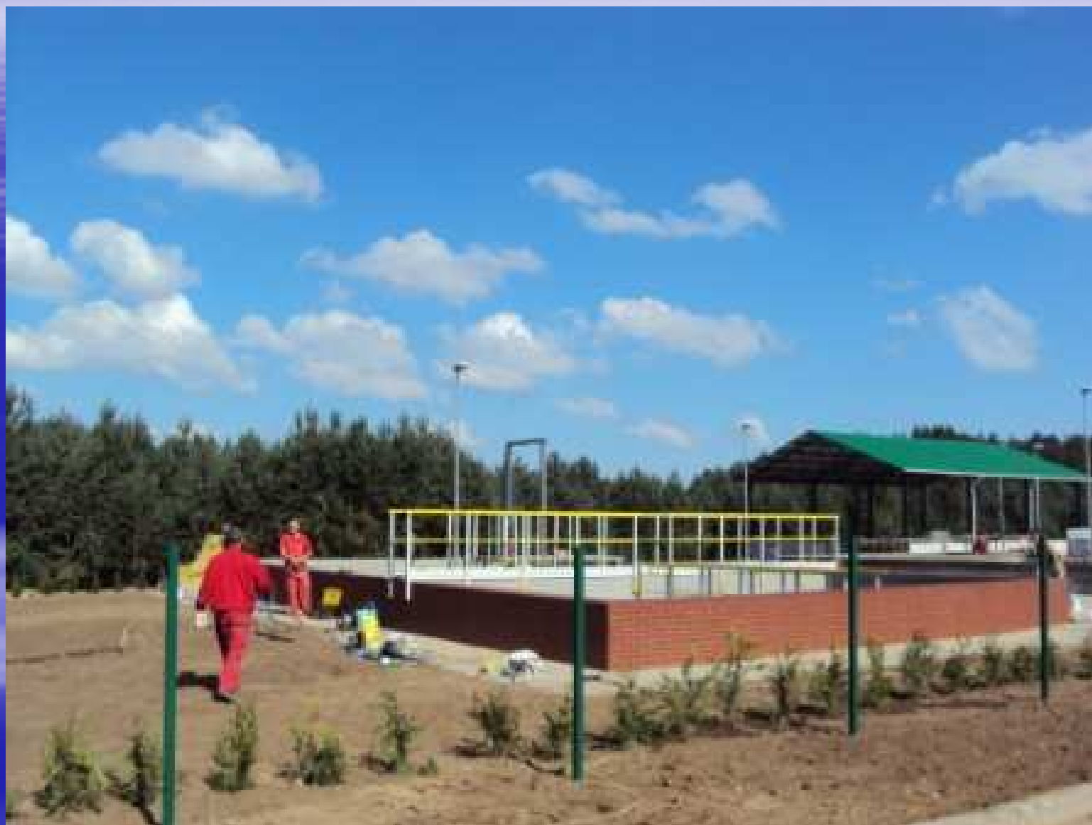
Rozbudowa oczyszczalni ścieków w Tłuczewie
