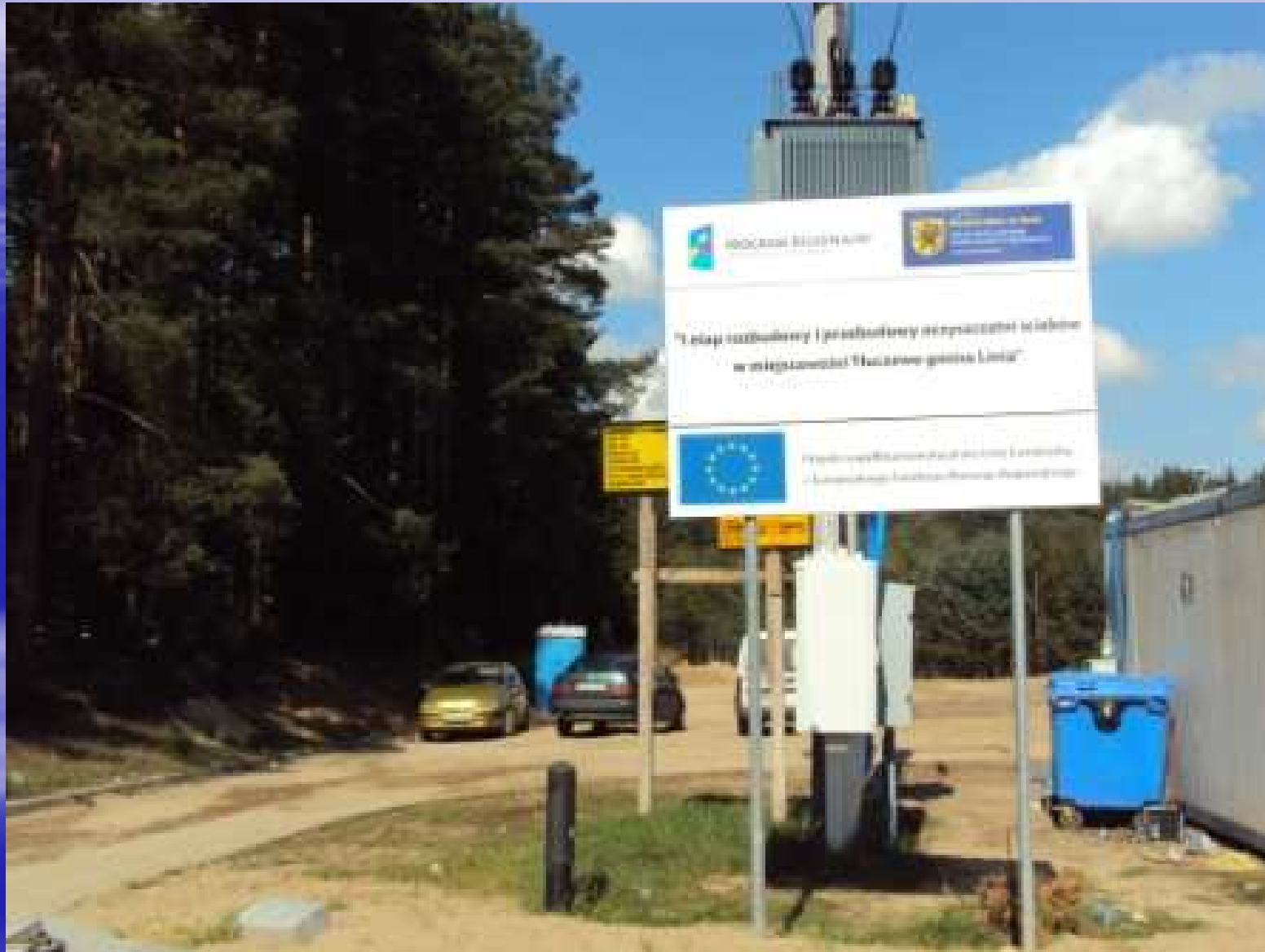
Rozbudowa oczyszczalni ścieków w Tłuczewie
