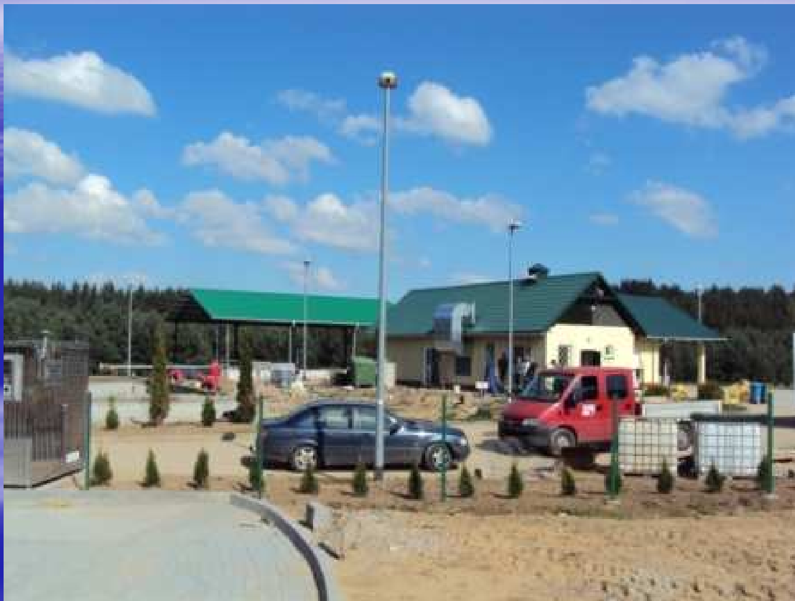
Rozbudowa oczyszczalni ścieków w Tłuczewie
