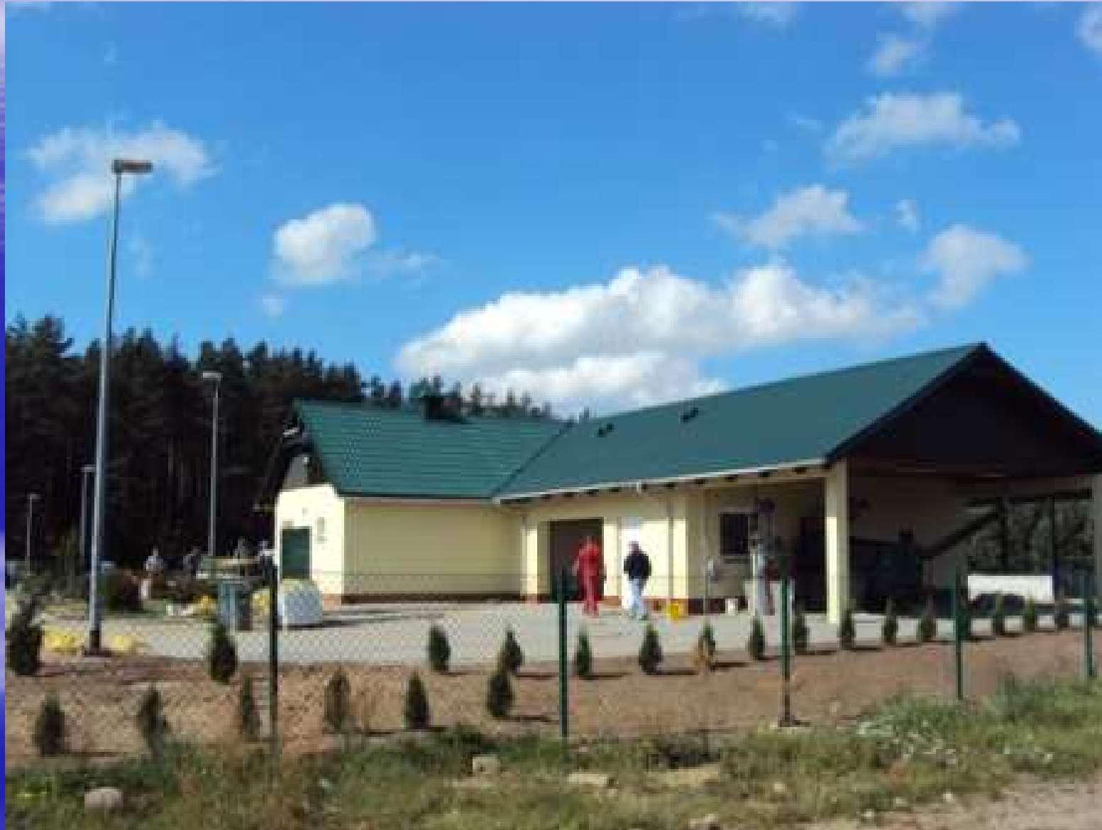
Rozbudowa oczyszczalni ścieków w Tłuczewie
