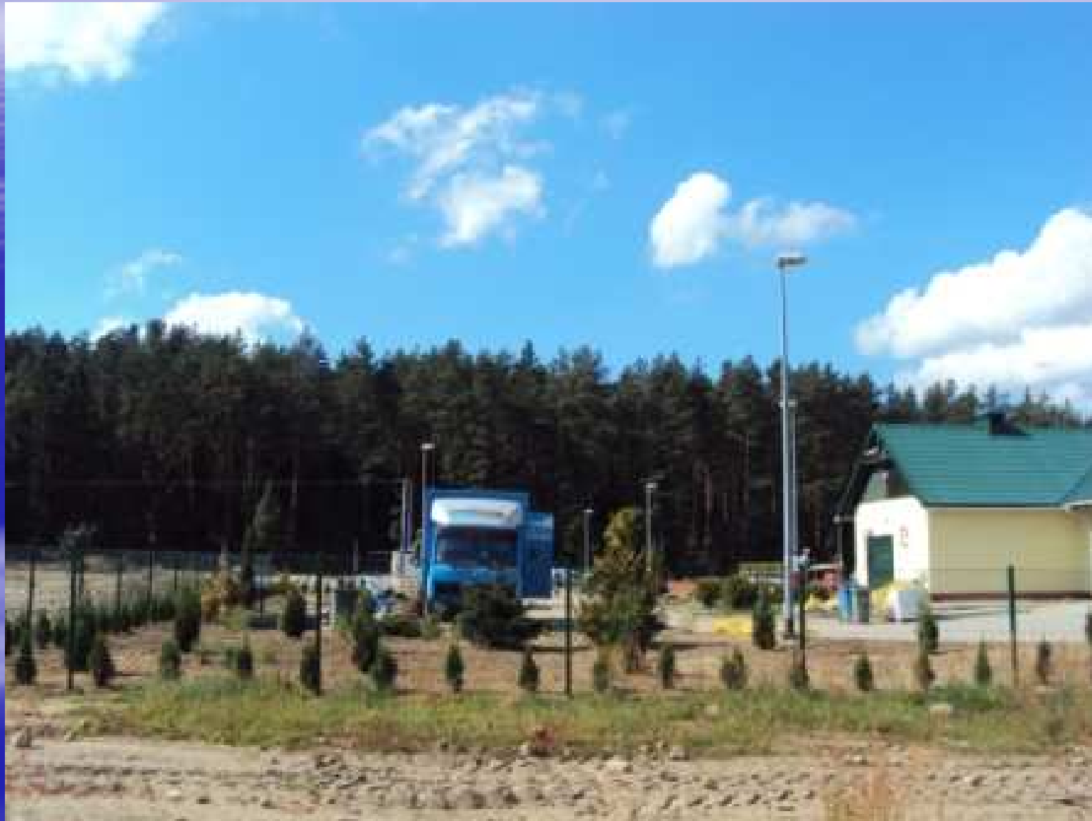
Rozbudowa oczyszczalni ścieków w Tłuczewie
