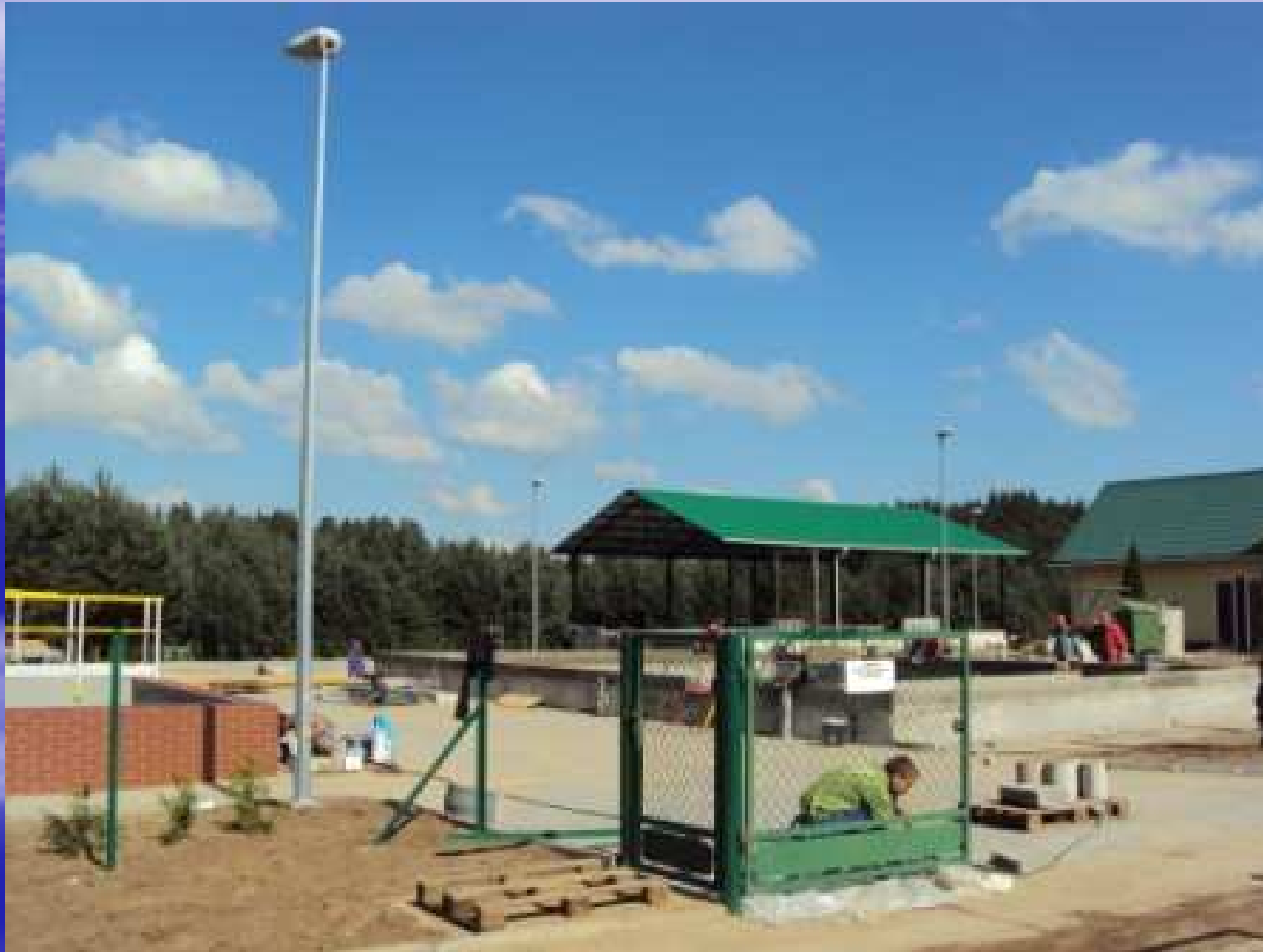
Rozbudowa oczyszczalni ścieków w Tłuczewie
