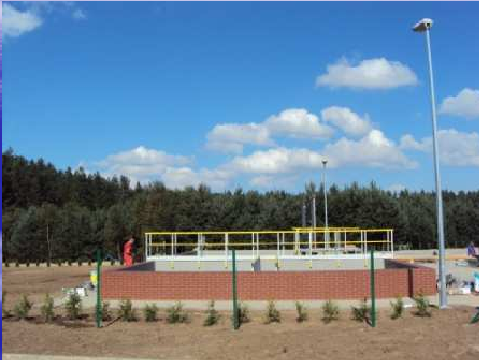
Rozbudowa oczyszczalni ścieków w Tłuczewie
