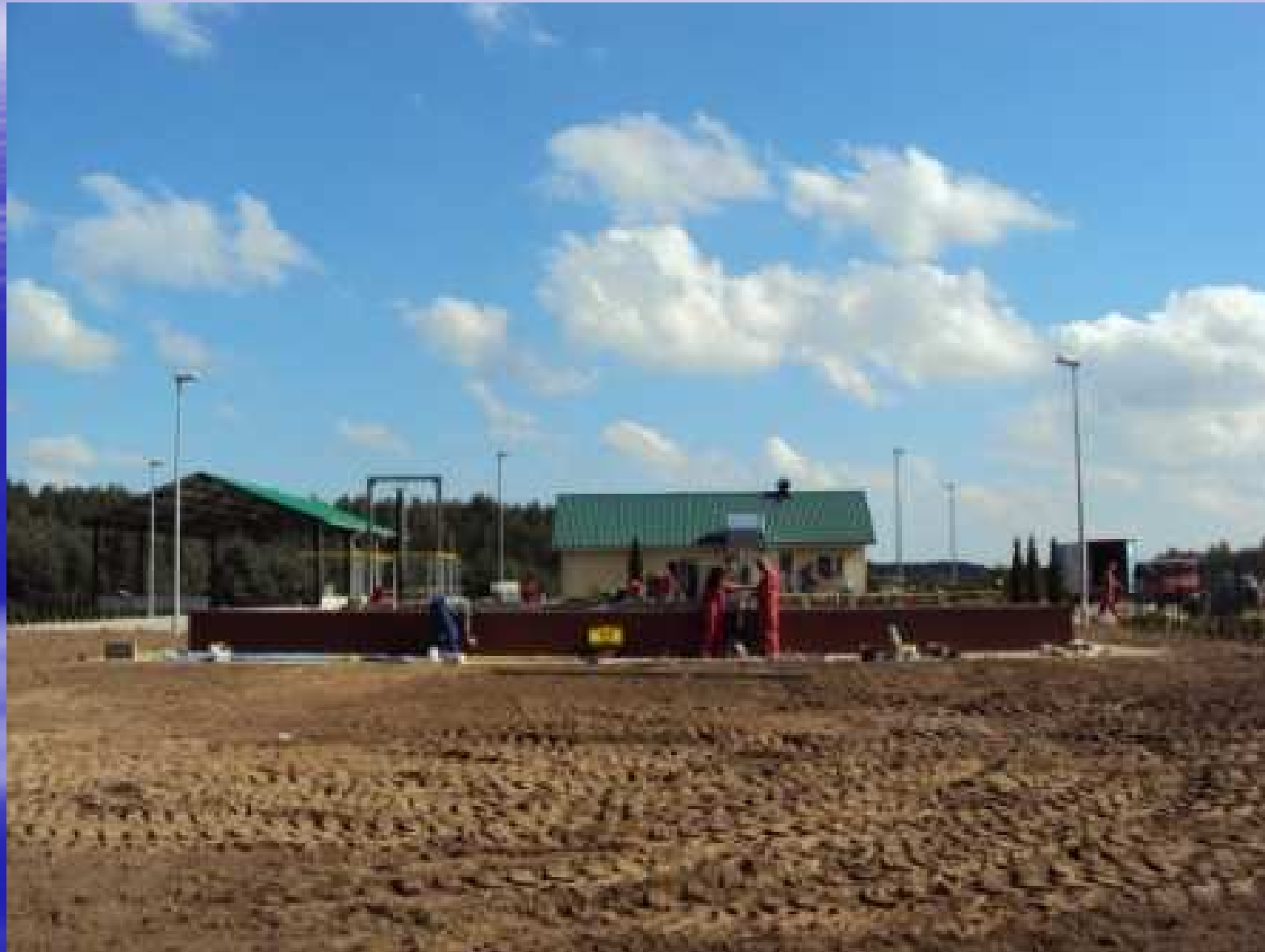
Rozbudowa oczyszczalni ścieków w Tłuczewie
